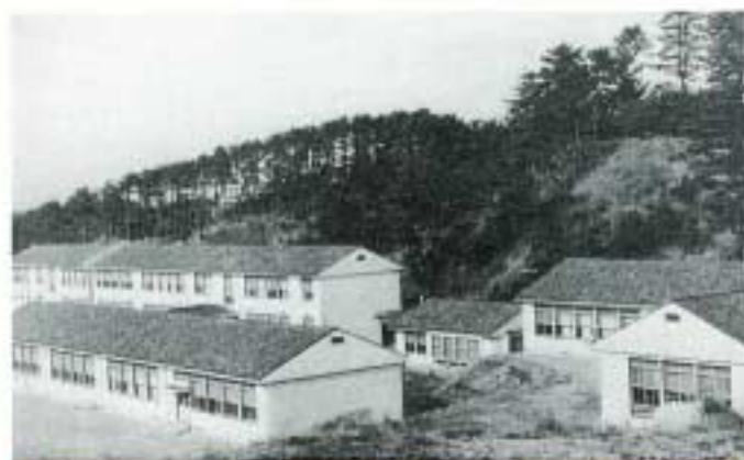
昭和26年（51） 新築された旧校舎
